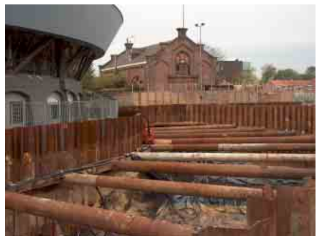
Figuur 4 Sanering Oostergasfabriek
