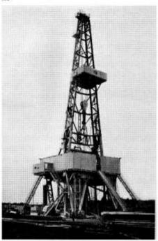
De vereiste nauwkeurigheid van de voorspelling van de deformaties door het gewicht van de boorstelling ligt in een heel andere orde van grootte; verschilzettingen van maximaal enkele centimeters werden acceptabel geacht. De maximaal berekende zettingen bedragen 63 mm, met verschilzettingen van 43 mm.
